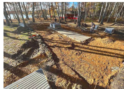
Prace przy budowie tężni solankowej w rejonie zalewu Chechto w Trzebini
