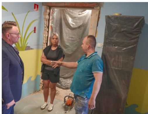
Dyrektorka Przedszkola Samorządowego nr 2 Edyta Surowiec omawia postęp prac w budynku
