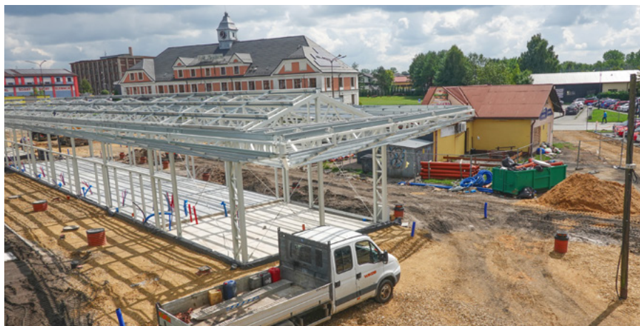
Nowy dworzec w budowie
