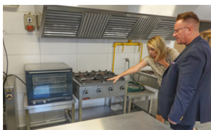
Kuchnia w przedszkolu w Myślachowicach nie przypomina tej sprzed wakacji. Wymieniono tam sprzęt i wyremontowano całe pomieszczenie
