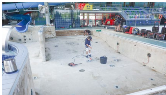
Trwa wymiana folii ochronnej w basenie rekreacyjnym
