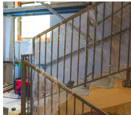
W ramach zadania wykonano nowe schody łączące piwnicę, parter i pierwsze piętro
