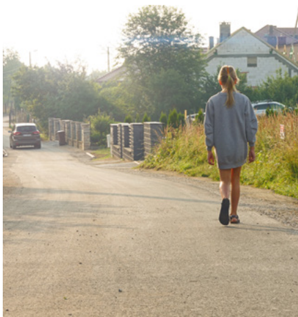
Przebudowany odcinek ul. Ostra Góra w Myślachowicach
