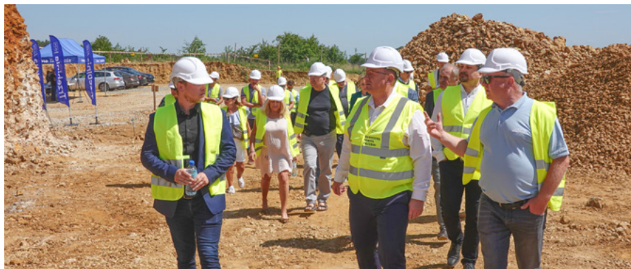
Na placu budowy nowego osiedla Vidok Residence w Trzebini
