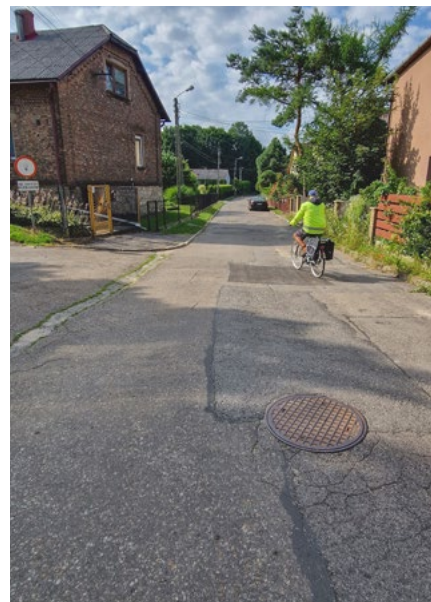
Ul. Kościelna zyskała nową nawierzchnię, ale tylko do wysokości kościoła. Na asfalt czeka jeszcze odcinek do skrzyżowania z ul. Starowiejską
