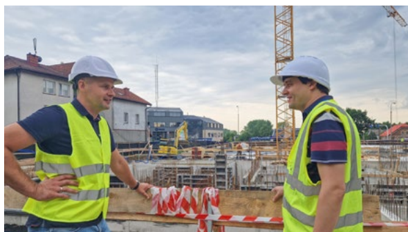
Krzysztof Gajda z krakowskiej firmy RUKO, który dowodzi na budowie oraz Edward Partyka, kierownik budowy z ramienia Gminy
