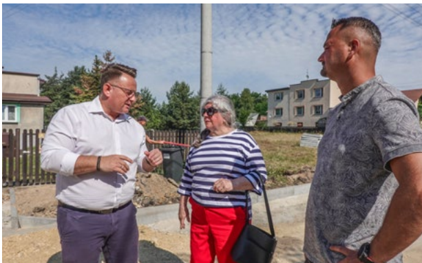
Prace na ul. Trzeciej dobiegają końca. Plac budowy odwiedził burmistrz Jarosław Okoczek, radna Bożena Adamczyk oraz Tomasz Glazer, zastępca naczelnika wydziału rozwoju w Urzędzie Miasta w Trzebinii
