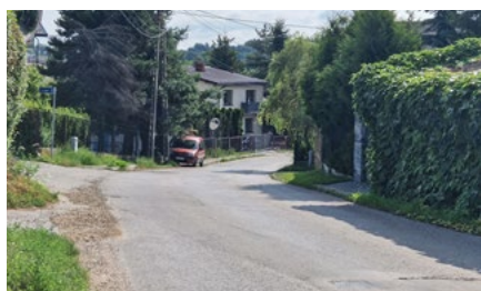
Ul. Emilii Plater na osiedlu Wodna. Nowa nawierzchnia pojawi się tam, gdy wodociągi zakończą wymianę sieci
