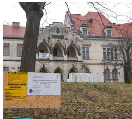
Trwa remont zespołu pałacowego w Młoszowej
