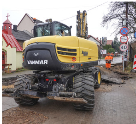
Trwają prace na ul. Plater w Trzebinii
