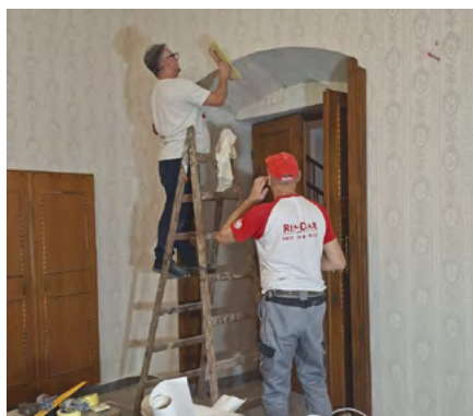
Prace remontowe w sali Dworu Zieleniewskich
