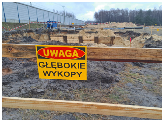
Na placu budowy nowego wiaduktu i połączeń drogowych w Młoszowej
