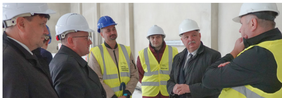
Na placu budowy nowej sali gimnastycznej w Bolęcinie
