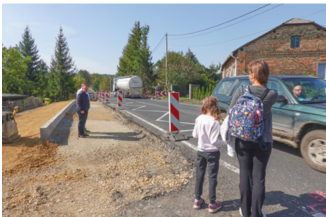
Piesi nie będą musieli chodzić poboczem. Przy drodze wojewódzkiej w Lgocie powstaje kolejny odcinek chodnika
