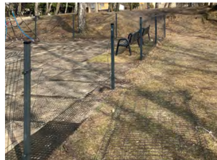
Zniszczony plac zabaw przy ul. Ogrodowej w Sierszy
